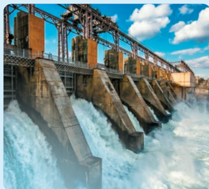
Камбар-Атинская ГЭС-1 в Кыргызстане
