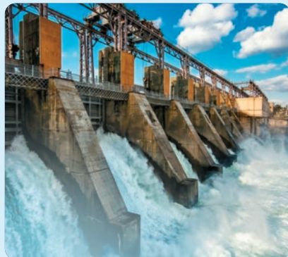
Камбар-Атинская ГЭС-1 в Кыргызстане
